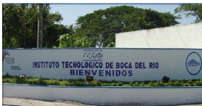
Fig. 1. Fachada de las instalaciones del ITBOCA.
