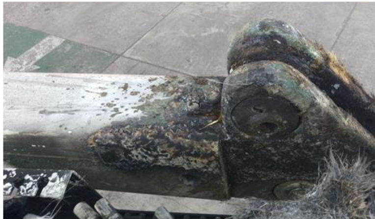
Figura 7, Daño en área de control superior en la canastilla.
