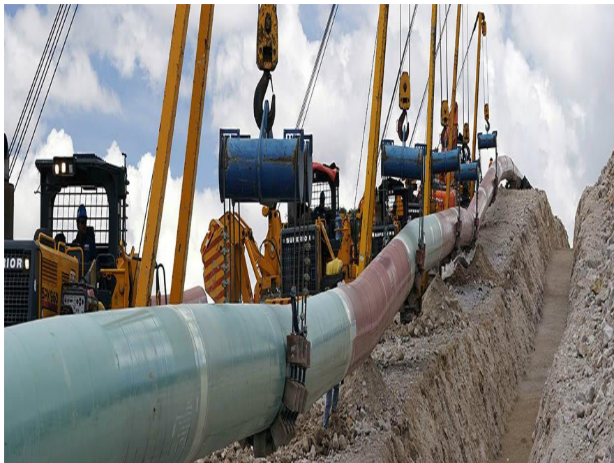
Fig. 4. Hincado de tubería en zanja [9]
