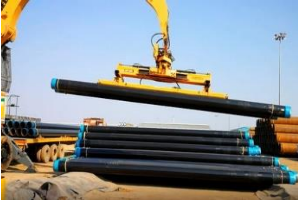
Fig. 2. Transporte de tubería [8]
