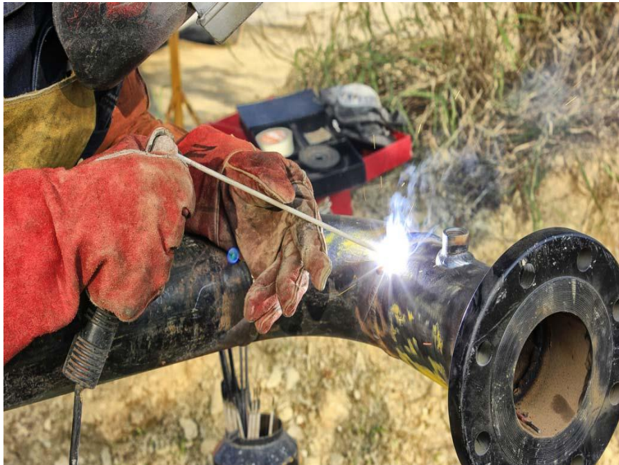
Fig. 3. Aplicación de soldadura [9]
