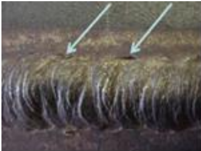
Fig. 19. Socavado en soldadura [16]
