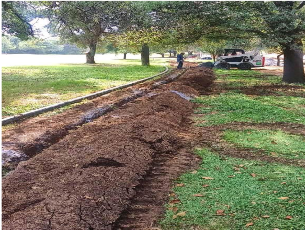
Fig. 5. Tapado de tubería [9]
